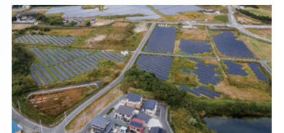
S-63 福島相馬原釜1号・2号 太陽光発電所
