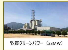
バイオマス 発電所
